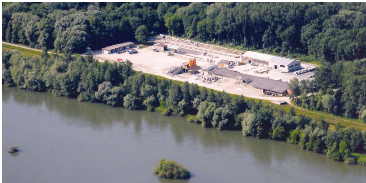
Negdašnji pogon Zagorje Tehnobetona gdje se gradi nova varaždinska dvorana
