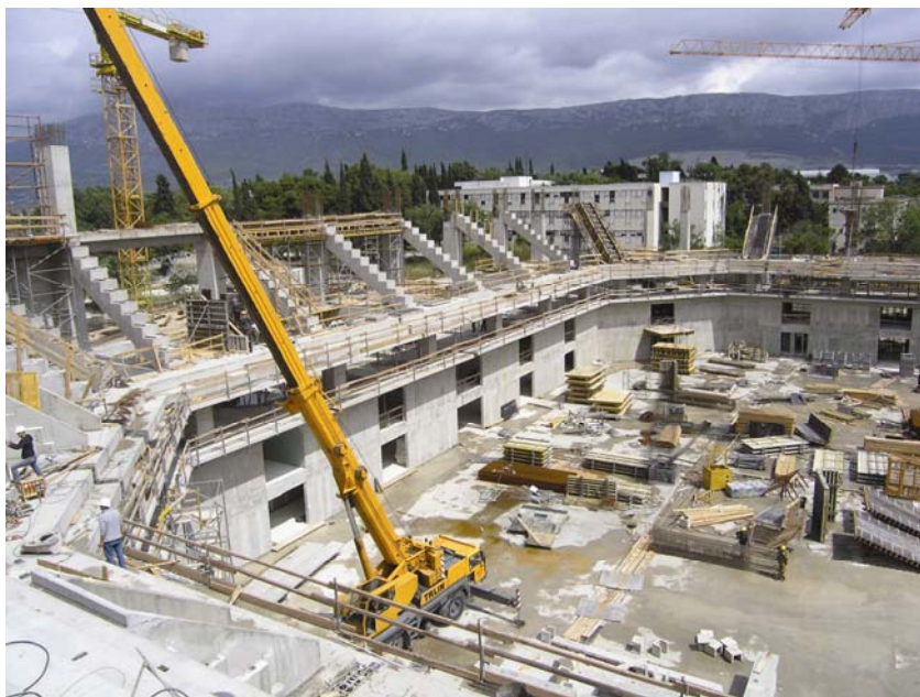
Gradilište športske dvorane u Splitu
