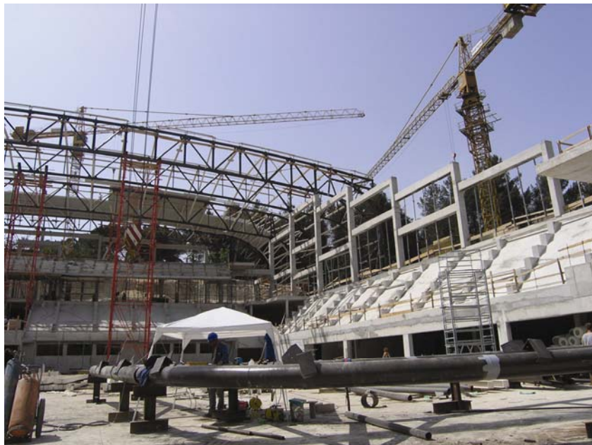
Gradilište višenamjenske dvorane Žatika u Poreču
