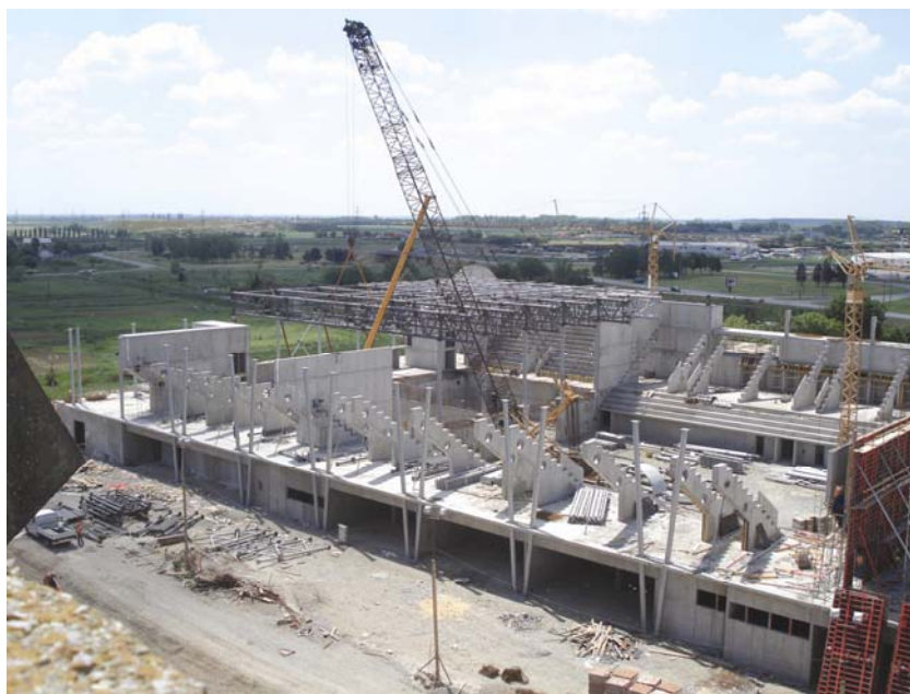
Gradilište osje ke dvorane
